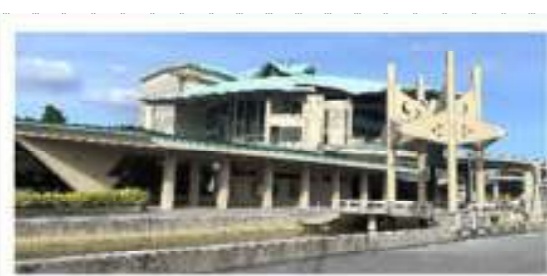
沖縄コンベンションセンター
