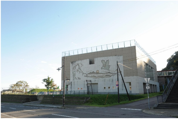
羅臼小学校体育館外壁
