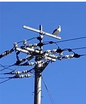
鳥の感電事故を防ぐために建てられた電柱です。左の写真のような電柱もありますよ。
