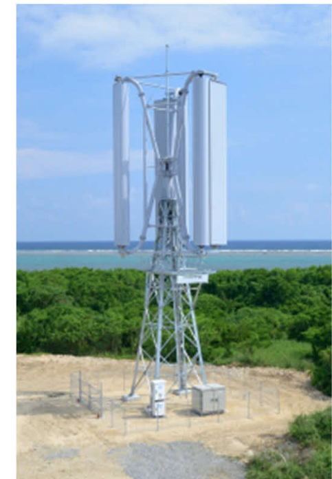
チャレナジー 垂直軸型マグナス風車 https://challengeenergy.com/magnus/
