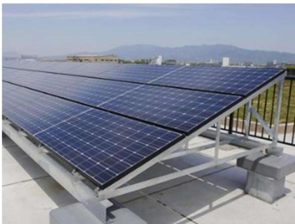
a) 鉄筋コンクリート造基礎
